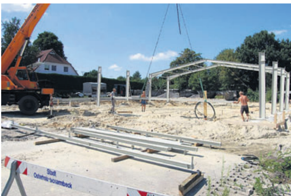
Auf dem Gelände des Baubetriebshofes in Pennigbüttel wird eine neue Gerätehalle errichtet. Am Donnerstag begann der Aufbau der Stahlkonstruktion. FOTO: MICHAEL RABBA
